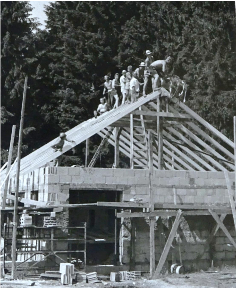
Richtfest im Herbst 1964, erster Bauabschnitt Vorgebäude
